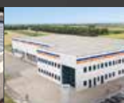
San Vito al Torre (UD)
